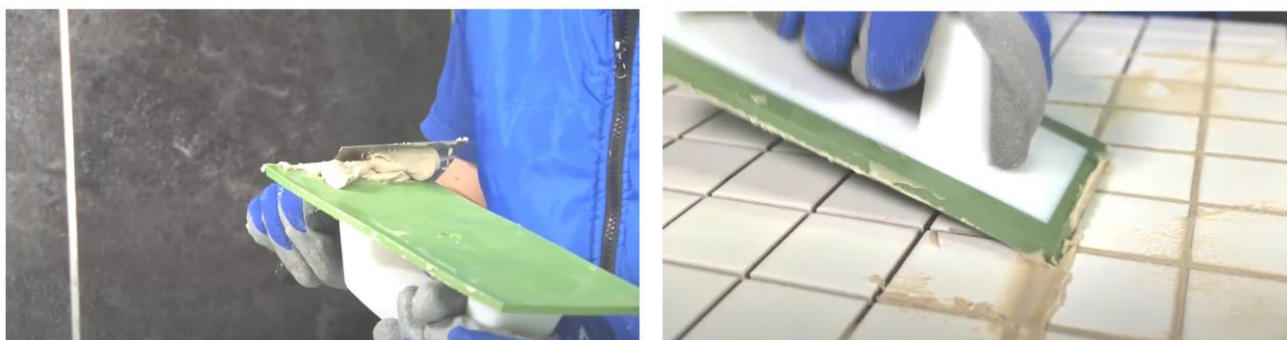
Рис. 38. Заполнение швов затиркой при помощи резинового шпателя
